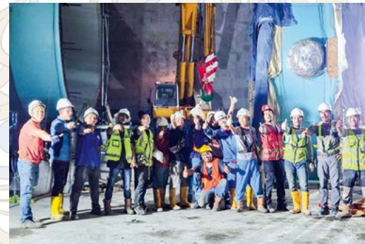
Equipo de montaje de la válvula de aislamiento de tubería forzada (PIV)
