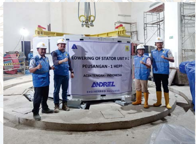
Bajada del estator de la Unidad 1 en Peusangan 1
