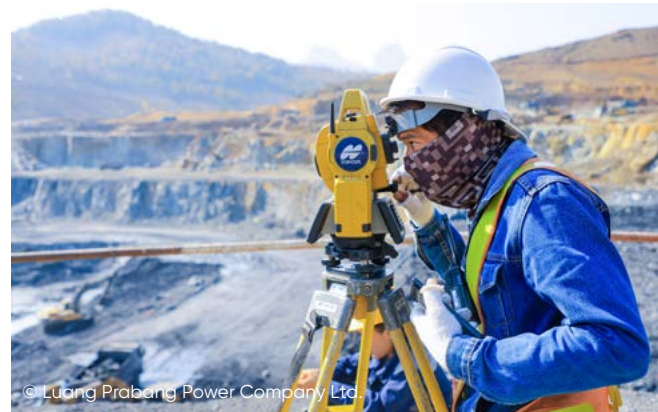
Trabajos topográficos en la ribera del río, al inicio de las obras civiles
