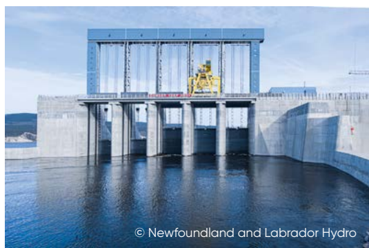
Compuertas de bocatoma, incluyendo rejas hidráulicas
