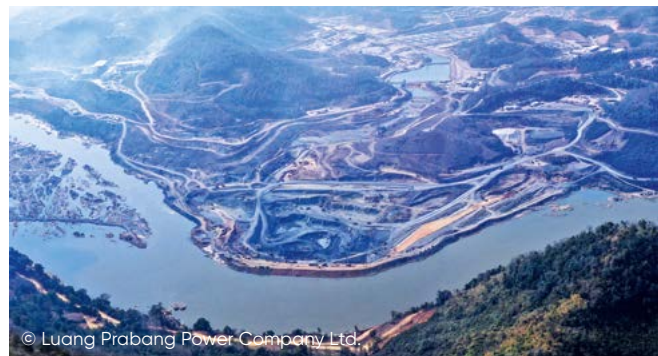
Vista general del sitio de construcción Luang Prabang
