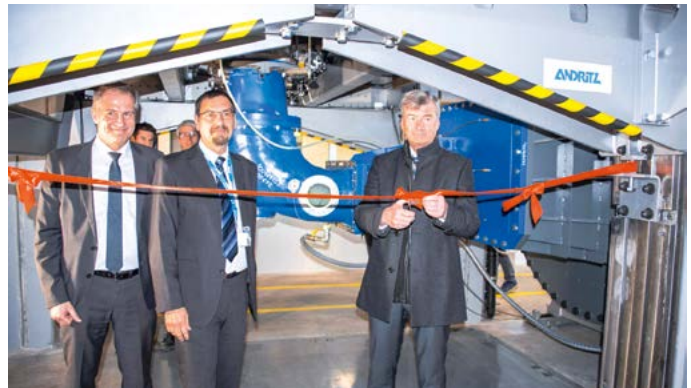
Inauguración oficial del banco de pruebas de alto rendimiento en Linz, Austria
