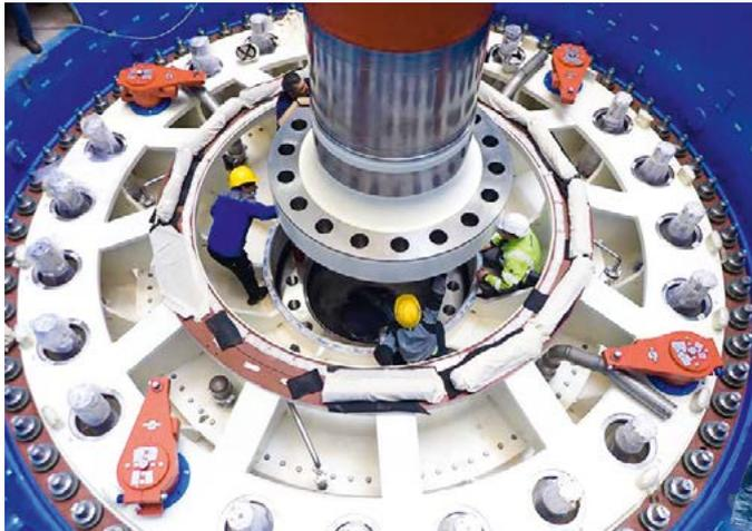
Installation de l'arbre de la turbine et l'appareil de guidage sur l'unité A-1
