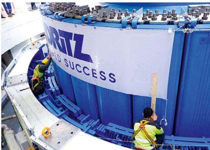
Installation du rotor de l'alternateur dans le puits de l'unité A-1
