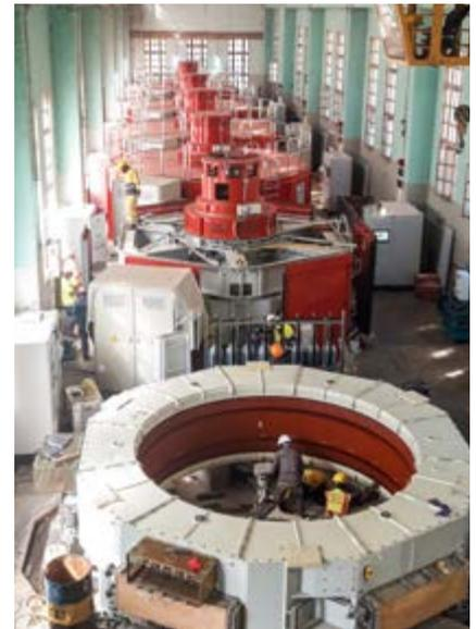
В результате реконструкции и модернизации мощность каждого гидроагрегата ГЭС «Mwadingusha» увеличится с 11,8 МВт до 13,05 МВт. Энергией ГЭС воспользуются жители Демократической Республики Конго, а также она будет использована для эксплуатации медного рудника Kamoa-Kakula.
