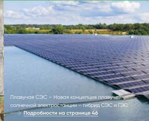
Плавучая СЭС – Новая концепция плавучей солнечной электростанции – гибрид СЭС и ГЭС
