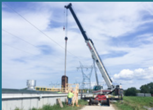
Puesta en servicio por primera vez en 1963/64, la planta se ubica en el Río Saskatchewan.
