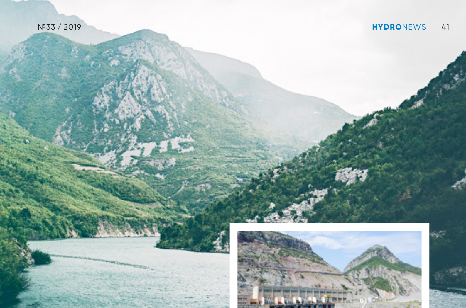
Con una capacidad de 600 MW, Komani se constituye en la mayor central hidroeléctrica de Albania y produce más del 30% de la demanda total de electricidad del país.
