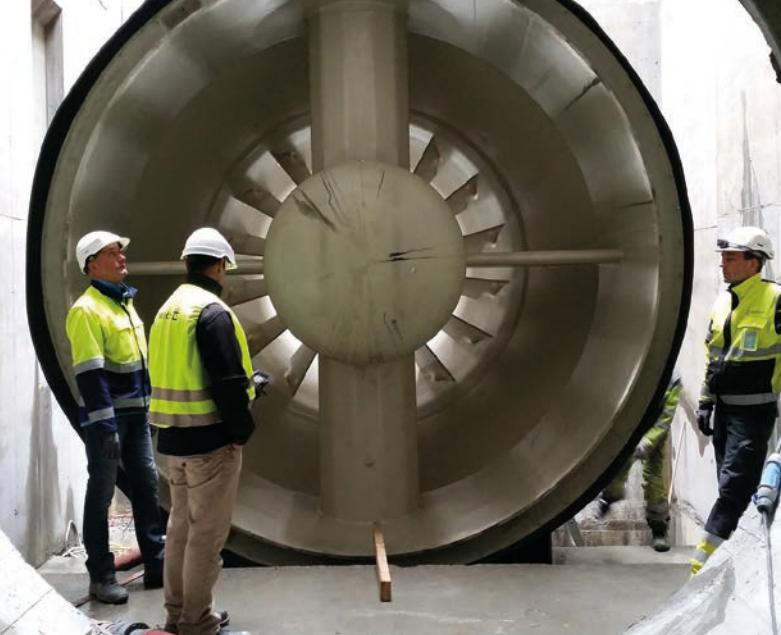
Монтажные работы на малой капсульной турбине
