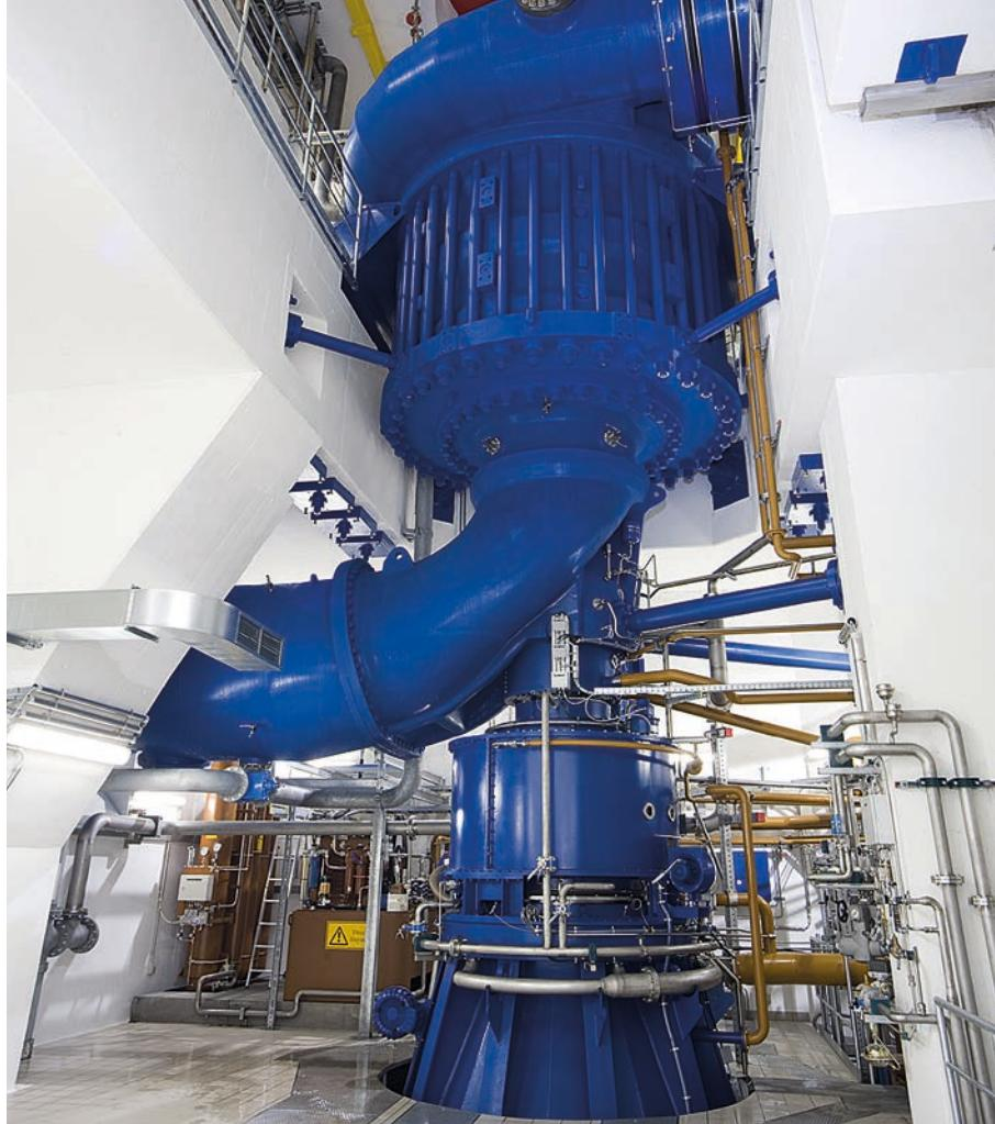
Четырехступенчатая обратимая гидротурбина
