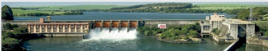
binado entre outros itens, a restauração da turbina, o fornecimento de um novo anel de descarga, a modernização do gerador substituindo o núcleo e enrolamento do estator, a renovação dos portões de entrada do rolamento, cabos de energia e painéis, novo sistema de excitação estática e de proteção, instalação e funcionamento. O início das atividades está previsto para setembro de 2014.
